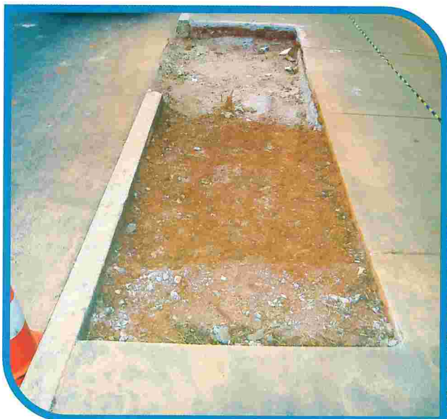
Início da reforma
