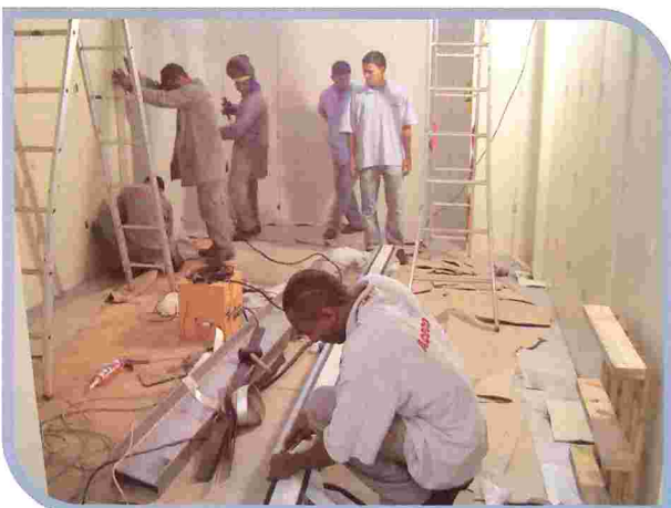
Montagem da Sala-Cofre
