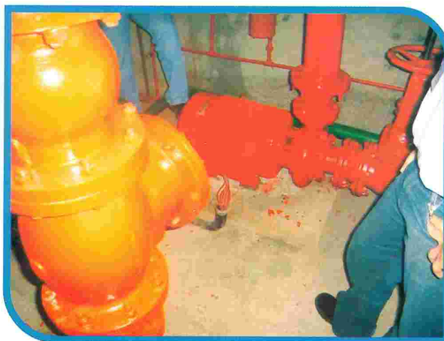
Substituição das bombas do Edifício Sede
