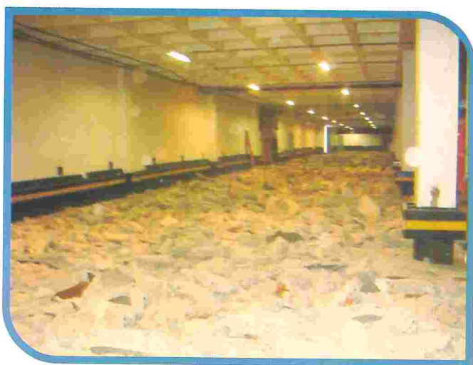
Início da reforma
