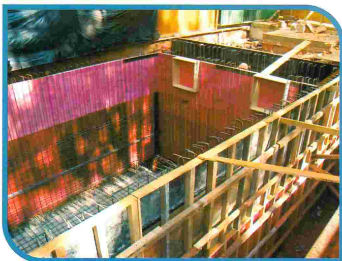
Formas e ferragem das paredes do reservatório
