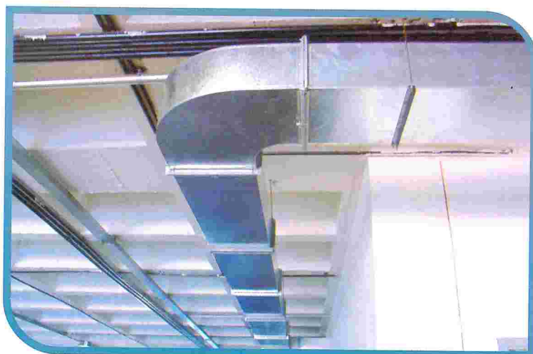
Instalação do exaustor finalizada
