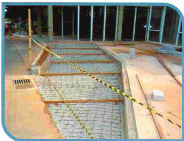
Início da construção
