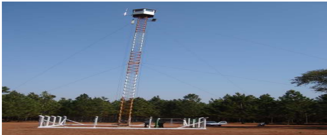
Figura 22 Torre de vigilância da empresa A
