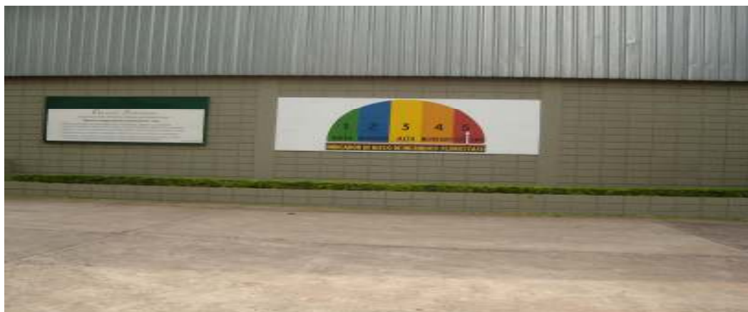
Figura 23- Quadro de risco de incêndio da empresa A
