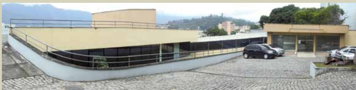
Foto 6 – Entrada do prédio Lélío Gama, construído para instalação de laboratórios geofísicos.
