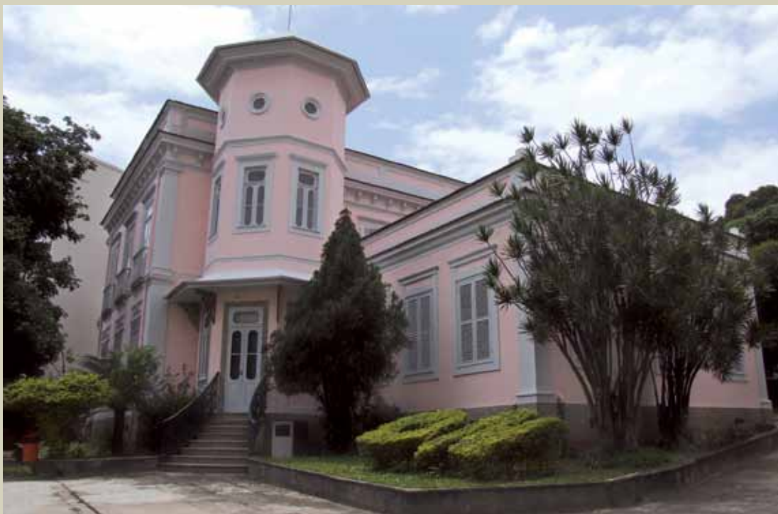
Foto 5 – Na antiga Casa do Diretor, hoje restaurada, está instalada a administração do ON.
