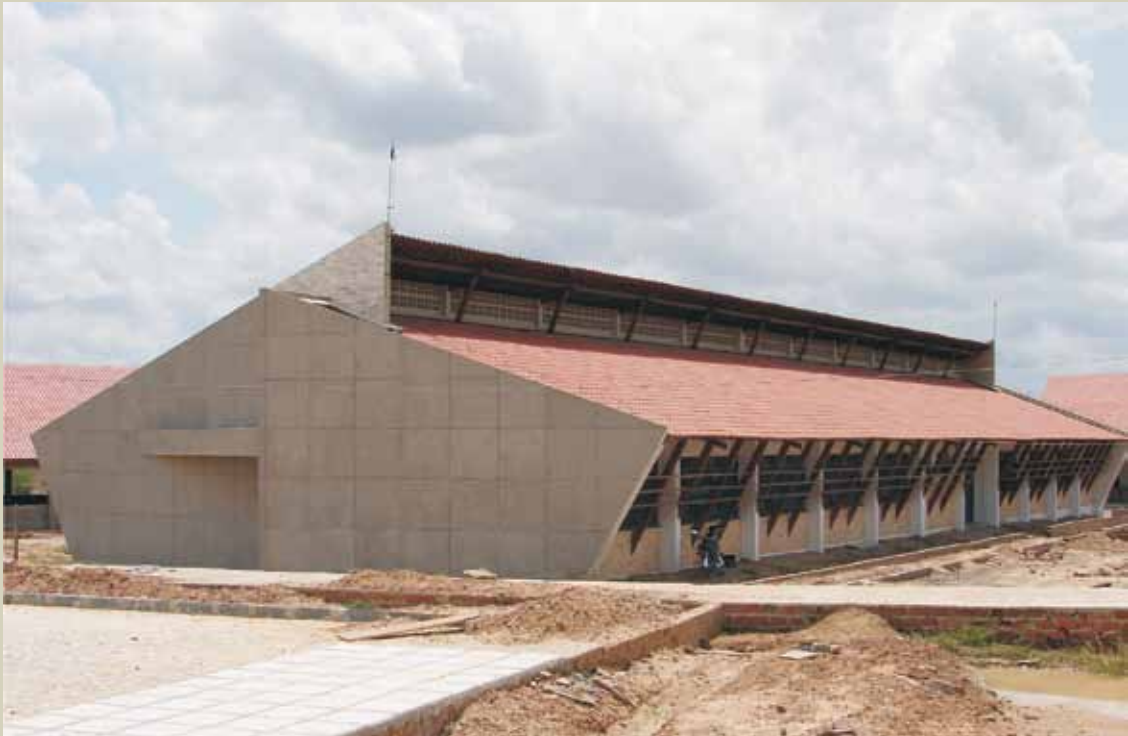
Figura 2. Bloco da Administração do INSA em sua etapa final de acabamento
