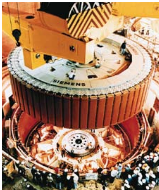
Geradores das usinas de Itaipu e de Três Gargantas: tecnologia desenvolvida no Brasil foi importante para fornecimento à China
