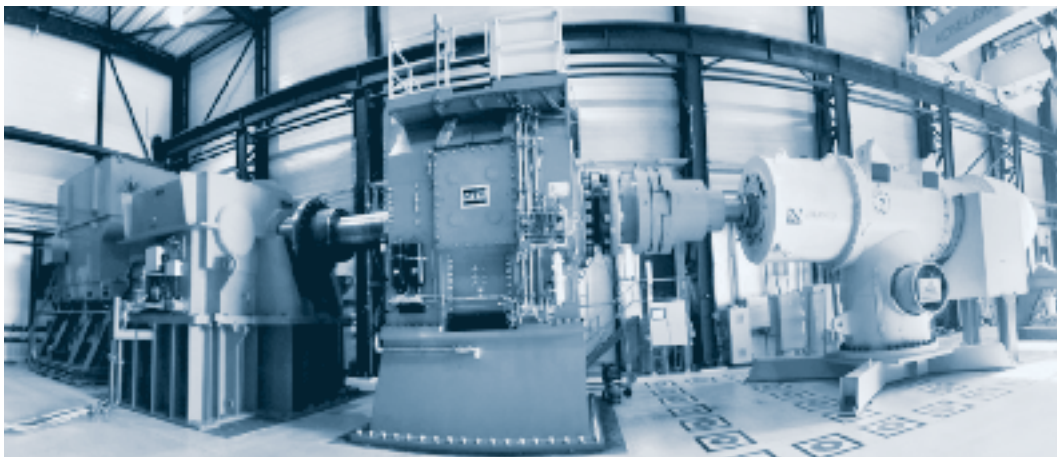
Figura 27 – Laboratório de teste de naceles com capacidade para até 3 MW
