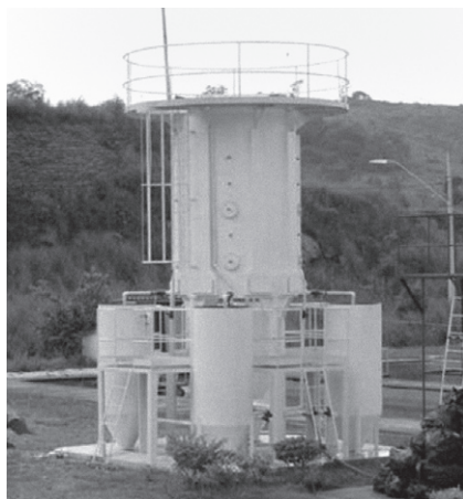
Figura 11.8 Reator UASB + filtro biológico percolador
