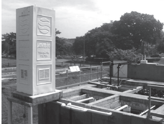
Figura 11.9 Filtro biológico percolador + decantadores secundários
