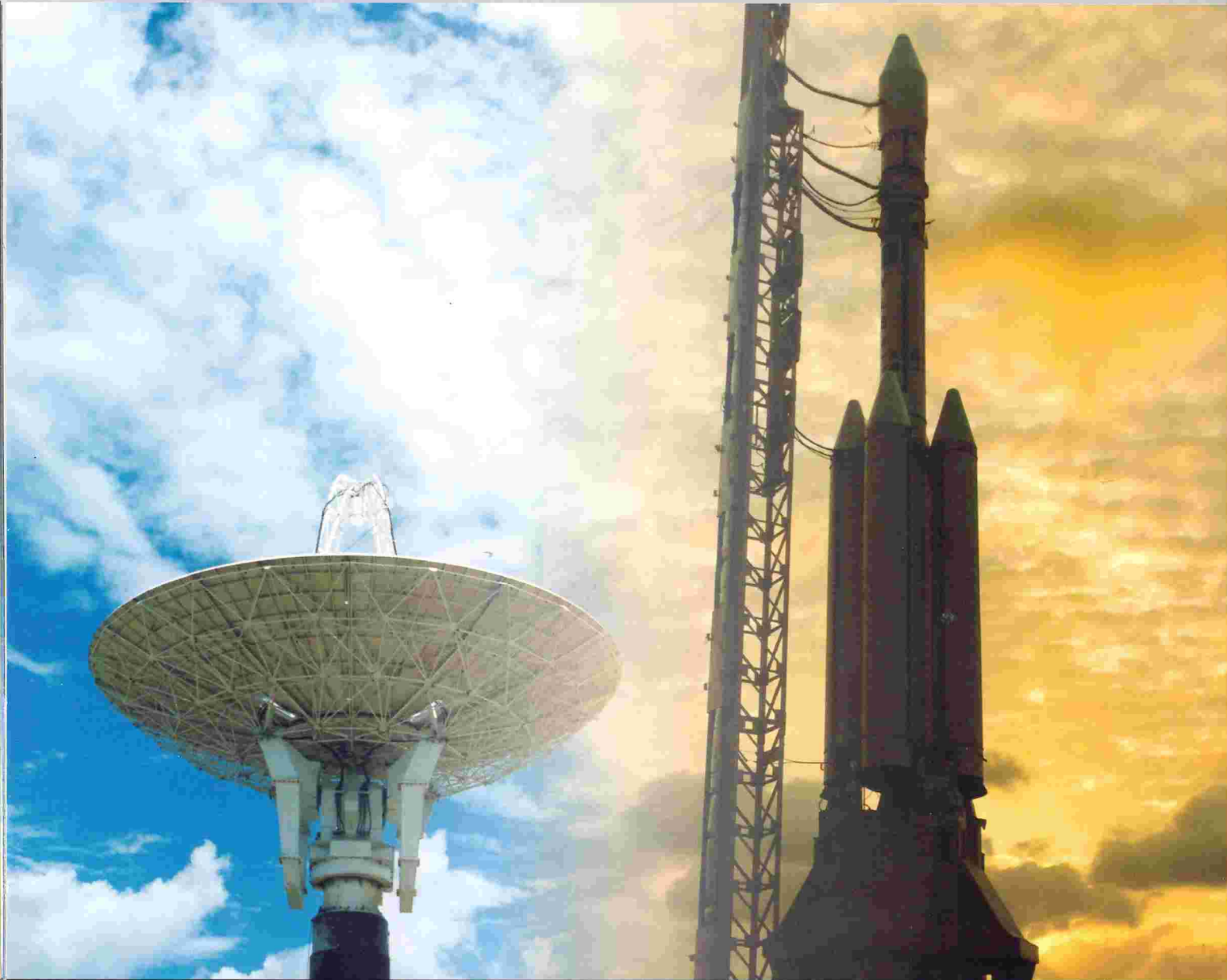
Radar de Telemédidas
