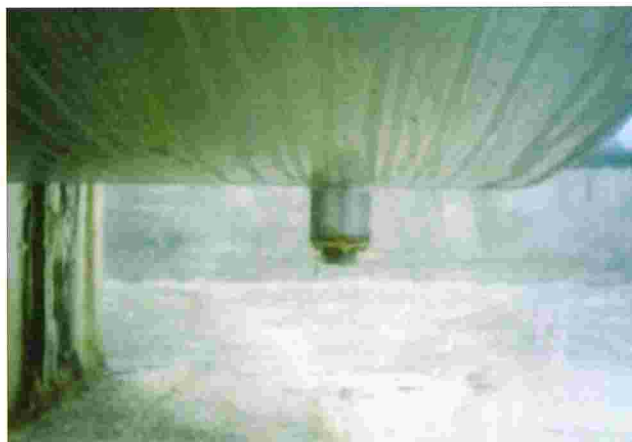
Figura 140: Sistema de drenagem de fundo de tanque bloqueado
