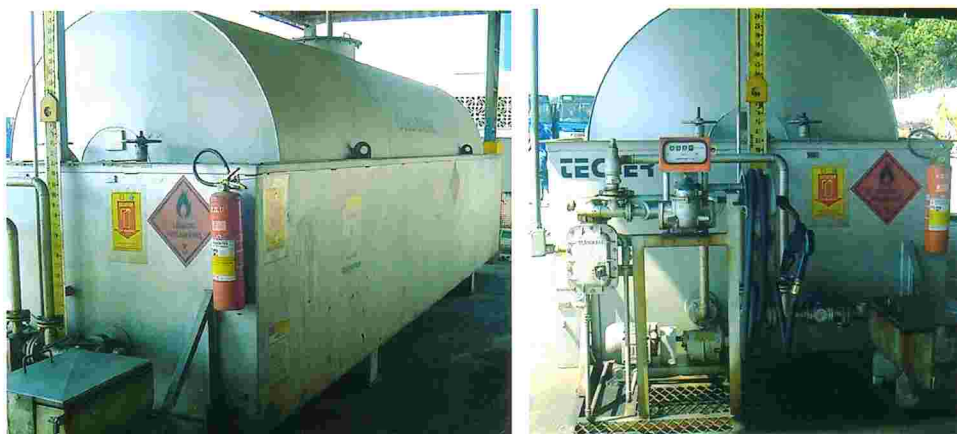
Figura 16: Infraestrutura de abastecimento da mistura B5 na Viação Cidade Dutra
