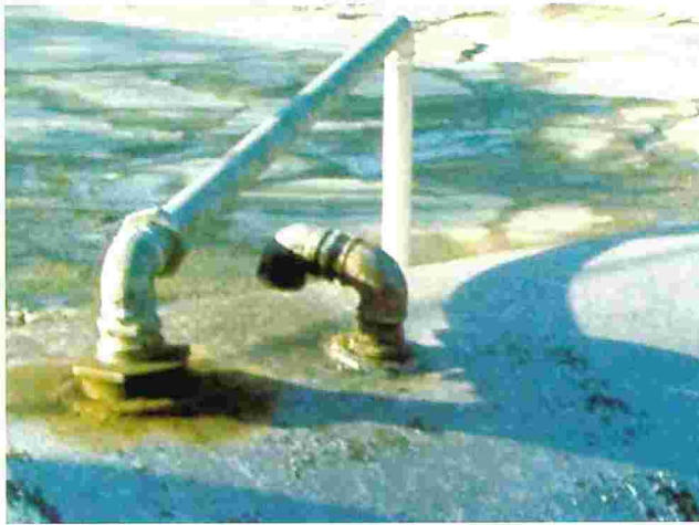
Figura 140: Sistema de drenagem de fundo de tanque bloqueado
