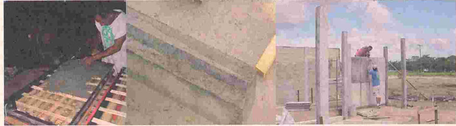
Protótipo de casa popular com sistema de painéis pré-moldados de microconcreto* estruturados com bambu. 42m - Silva, Alejandro, Sartori, Edson e Cardoso Jr, Ruben Instituto do Bambu - (SEBRAE-AL/UFAL) AL, 2004
