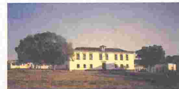
Figura 2 - Construção de terra crua em Goiás Velho, Go. Foto do autor
