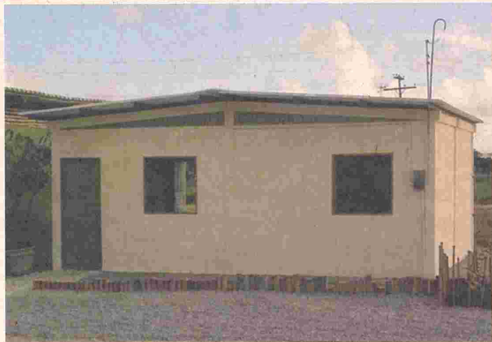
Protótipo de casa popular com sistema de painéis pré-moldados de microconcreto* estruturados com bambu. 42m - Silva, Alejandro, Sartori, Edson e Cardoso Jr, Ruben Instituto do Bambu - (SEBRAE-AL/UFAL) AL, 2004
