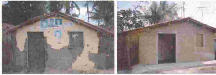
Figura 7 - Casa de terra sem e com tecnologia em favela na Paraíba
