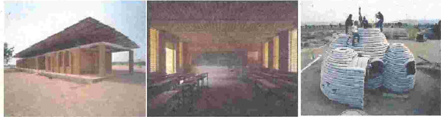
Figura 9 - Obras não convencionais premiadas: escola à base de terra crua e prototipo de refugio construído com sacos de areia. (Foto: Nader Khalili/ Cal-Earth Institute)
