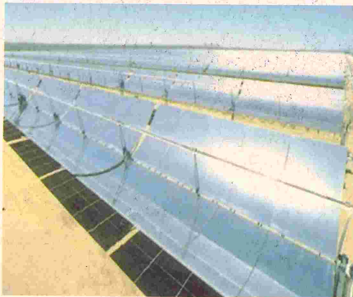
Concentradores solares de calha parabólica para geração de ener- gia elétrica. Foto: Professor Zhao Jun - Tianjin University
