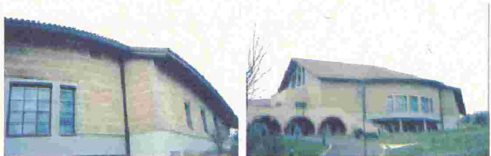
Figura 6 - Igreja na França associando materiais convencionais e não convencionais. Fotos do autor
