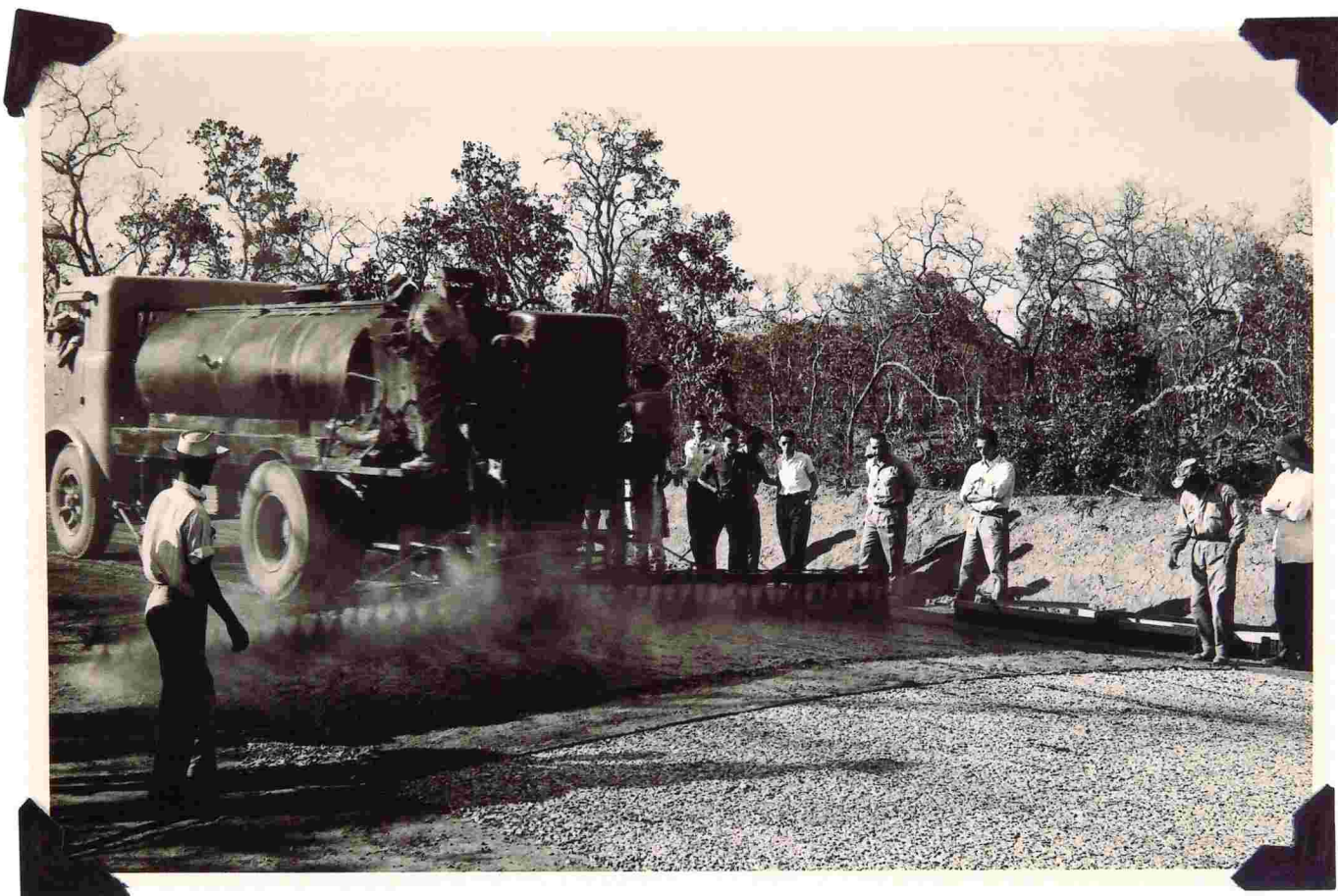
Vista de trecho da rodovia Belo Horizonte-Brasília, ainda em pavimentação, durante visita dos alunos do Curso de Especialização em Pavimentação Rodoviária, promovido pelo Instituto de Pesquisas Rodoviárias. (1959, autor desconhecido, Fundo CNPq)
